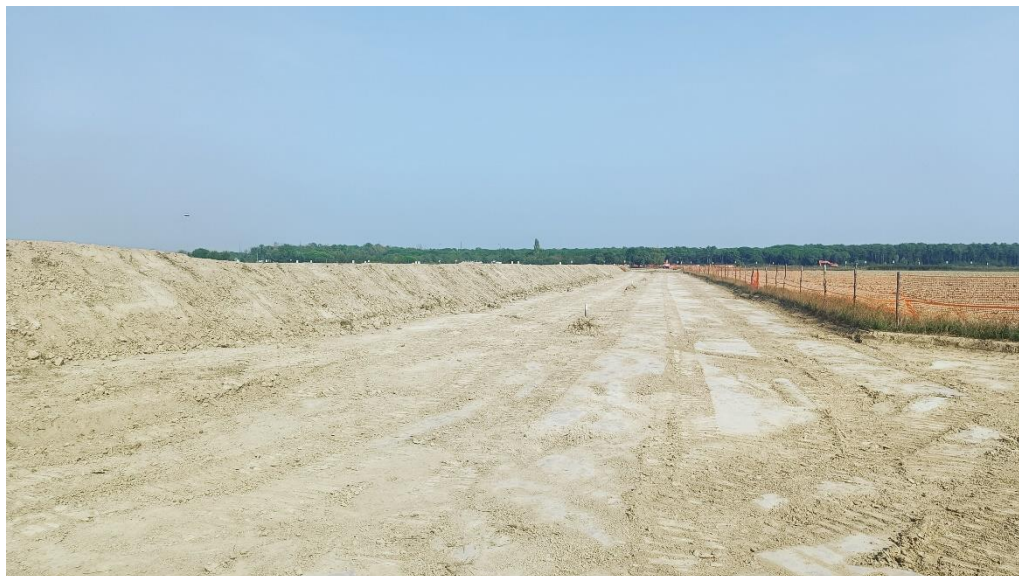
Fig 5 Apertura pista di lavoro e accantonamento strato humico in prossimità del P43 – lotto offshore parte a terra (Ottobre 2023)
